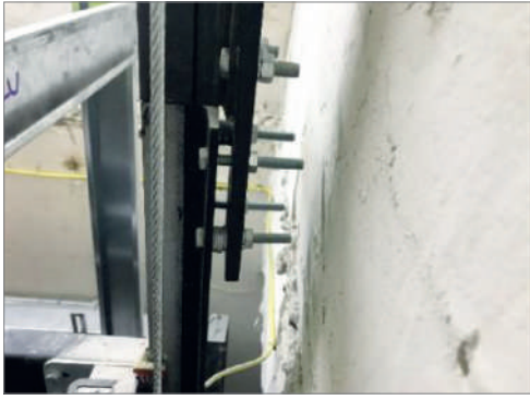
Resim-29 Kabin kılavuz ray bağlantısındaki hatalı imalat ray birleşimlerinin uyumsuzluğu
