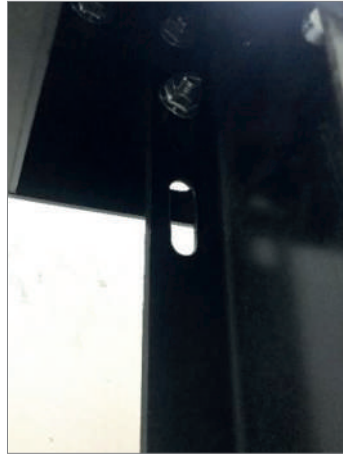
Resim-7 Karşı ağırlık karkas cıvata montaj/imalat hatası
