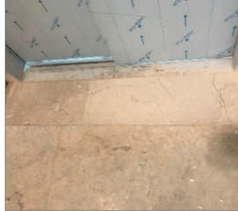
Resim-19 Kat kapı önü eşik önü ters eğim uygunsuzluğu
