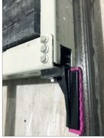
Resim-6 Kılavuz paten montaj hatası
