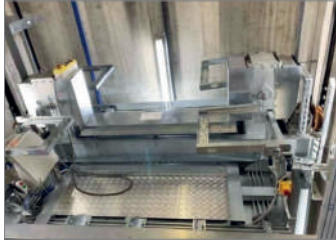
Resim-17 Kabin üstü katlanır korkuluk uygulama örneği
