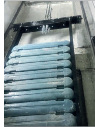
Resim-14 Karşı ağırlık paten bağlantısı (kırık paten)
