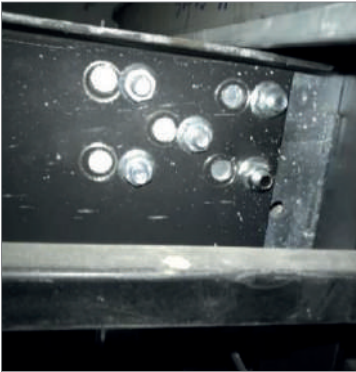
Resim-24 Güvenlik tertibatı aktarma kolunun montaj uygunsuzluğu
