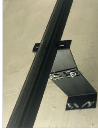
Resim-12 Kılavuz ray konsol bağlantısı montajı
