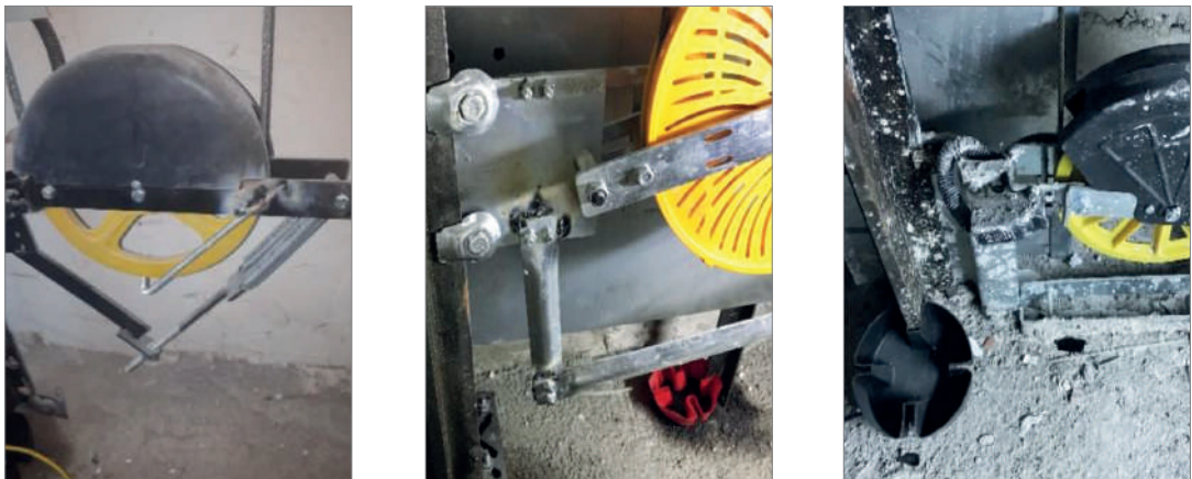
Resim-11 Regülatör gergi makarası montaj hatası
