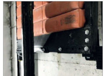
Resim-8 Yetersiz dayanıma sahip karşı ağırlık karkası tampon çarpması sonrası görünüm
