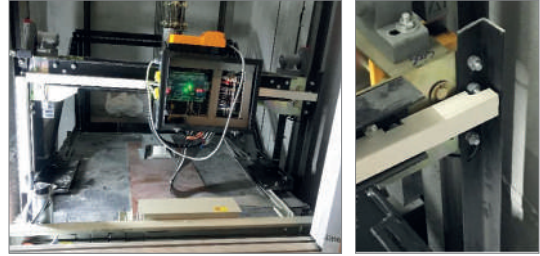
Resim-18 Kabin süspansiyon imalat ve montaj hatası
