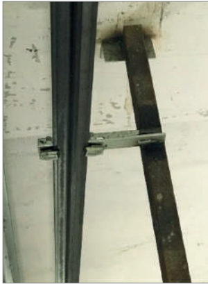
Resim-13 Konsol bağlantısının yetersiz bağlantısı
