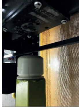
Resim-23 Karşı ağırlık tamponunun çarpma plakası önündeki güvenlik tertibatı aktarma kolu montaj uygunsuzluğu
