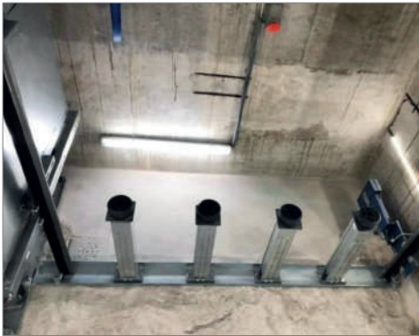
Resim-20 Kabin altı tampon montajı
