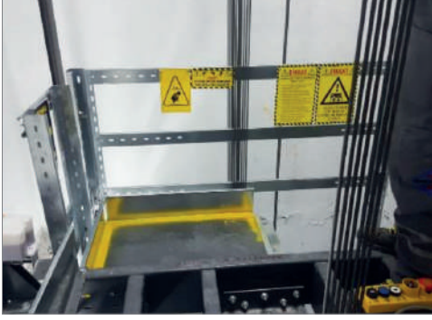
Resim-2a Kabin üstü oluşturulan güvenlik alanı ve işaretlemesi örneği
