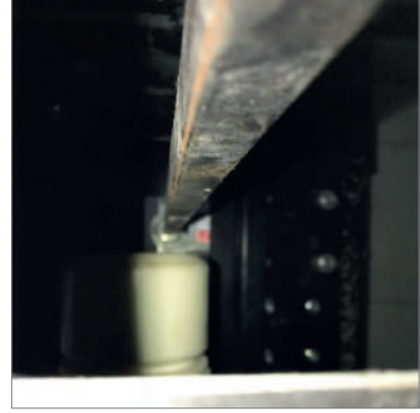
Resim-23 Karşı ağırlık tamponunun çarpma plakası önündeki güvenlik tertibatı aktarma kolu montaj uygunsuzluğu
