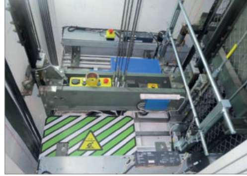
Resim-2b Kabin üstü oluşturulan güvenlik alanı ve işaretlemesi örneği
